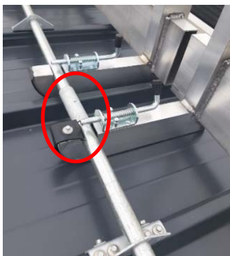
Abbildung 20: Montage der Muffe
