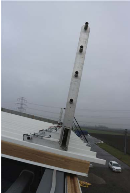
Abbildung 19: Beispielfoto Montage TRABS
